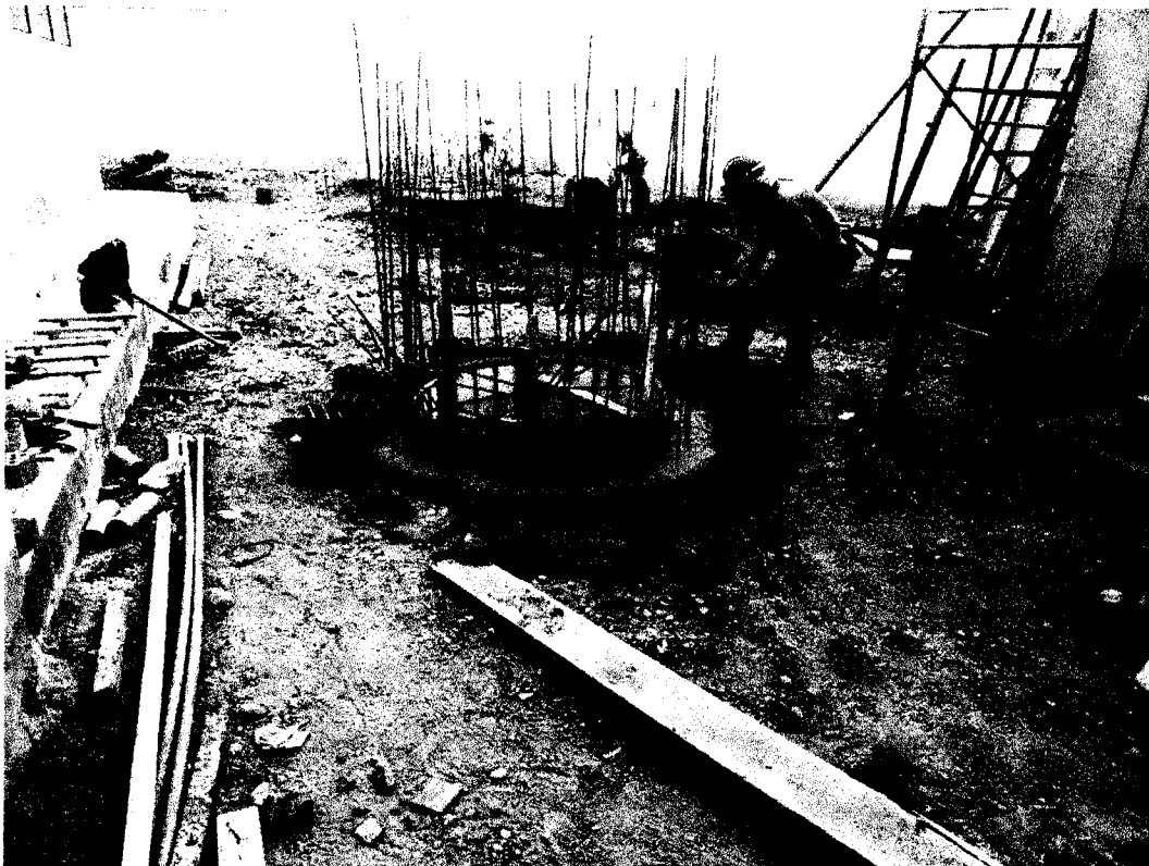
Foto N° 04: Vaciado de concreto en pozos de recolección.
