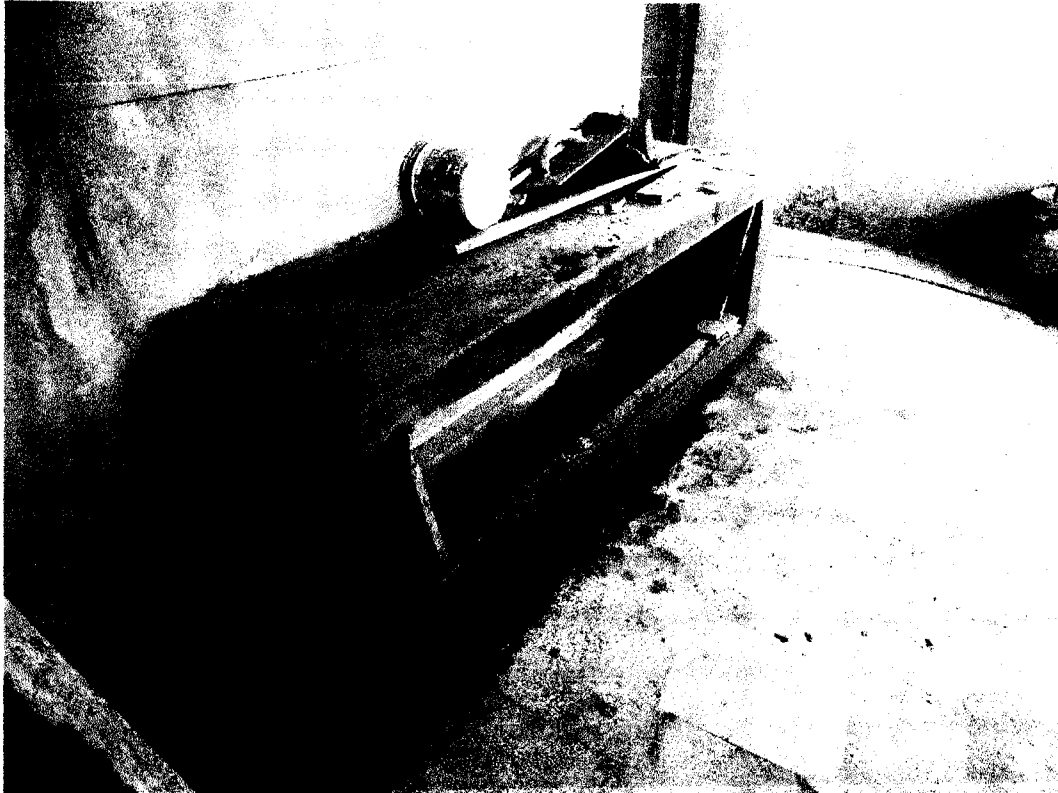
Foto N° 05: Ducto de ventilación SSHH Servicios Complementarios.
